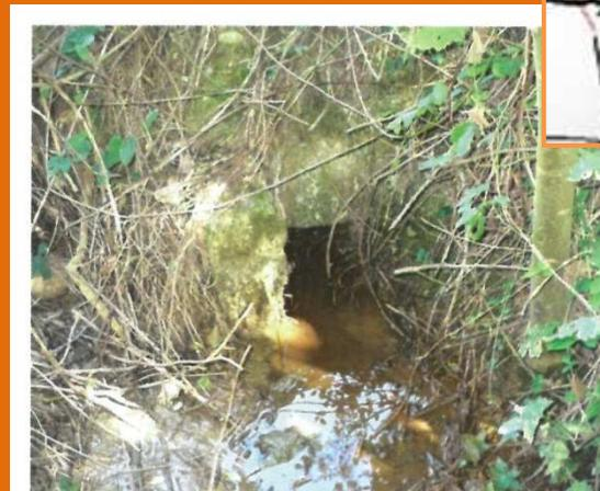
Sortie vidange dans le parement aval du barrage
