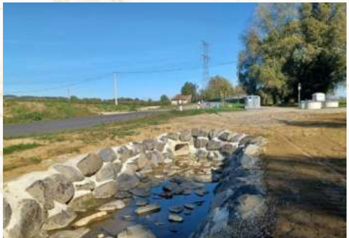
Exutoire du bassin de rétention du chemin du mulet.
