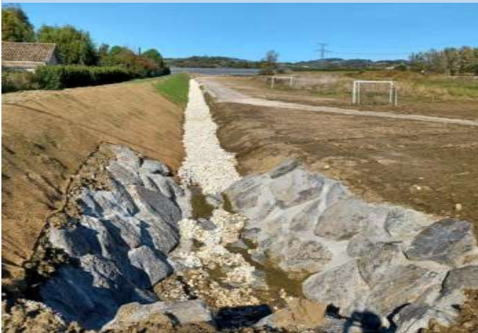
Digue de protection à l'Est du village
